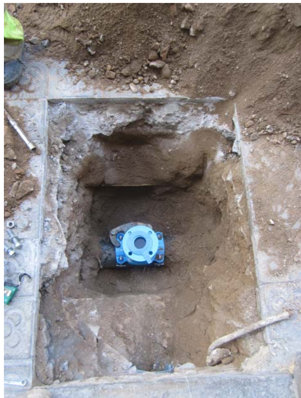
4. Detall de la fonamentació de l'edifici i la canonada d'aigua.
