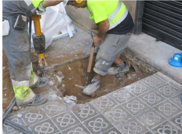
2. Treballs d'obertura del sondeig
