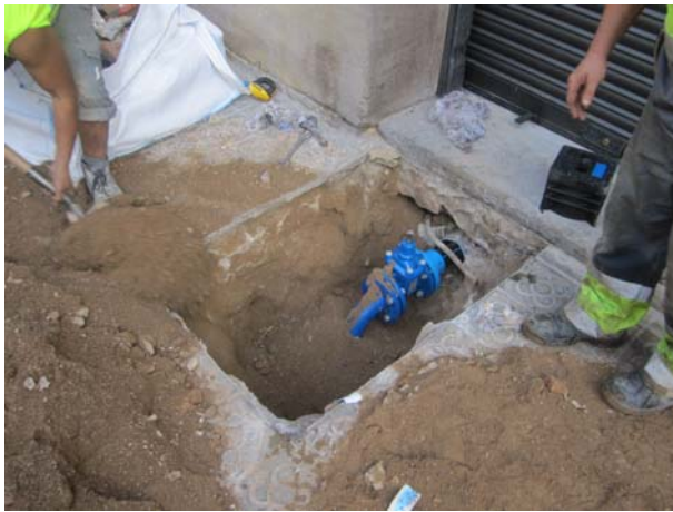
5. Operaris tornant a tapa el sondeig amb el mateix sediment.
